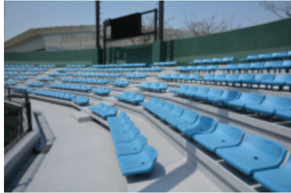
安城市ソフトボール場A球場改修期間(2016年10月~2018年3月)
