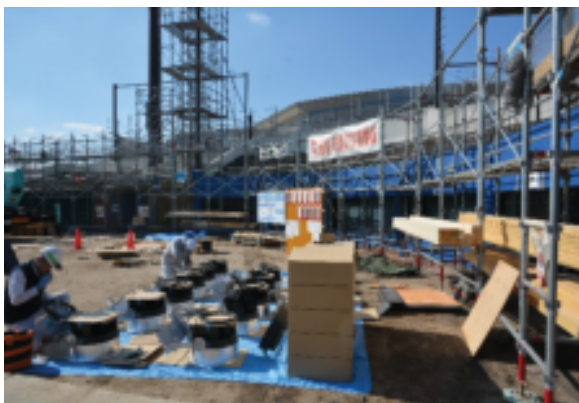
安城市ソフトボール場A球場改修工事(2017年)
