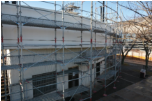
安城市ソフトボール場A球場改修工事(2016年)
