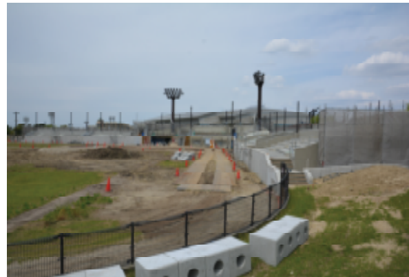
安城市ソフトボール場A球場改修工事(2017年)
