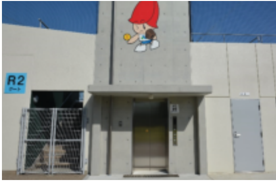
車椅子用エレベーター入口
