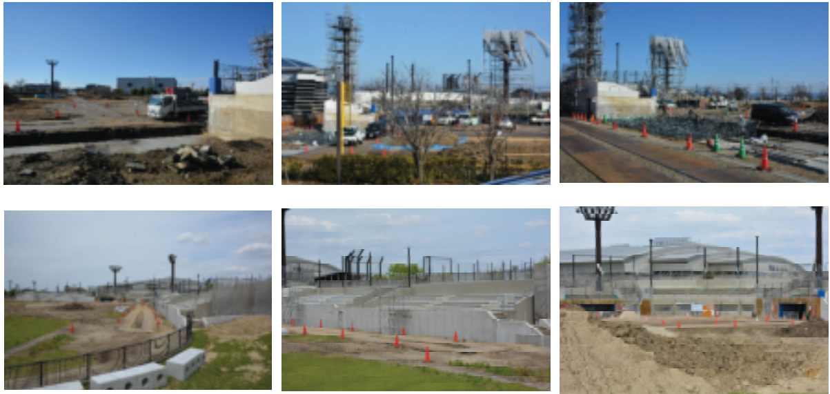
安城市ソフトボール場A球場改修工事の様子
